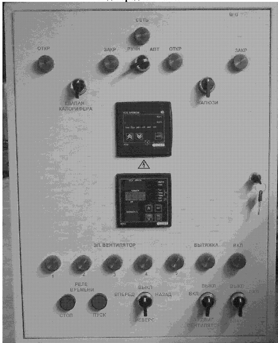
В режиме при включении таймера реле времени происходит пуск эл/вентиляторов с их реверсом, заданным промежутком времени.
